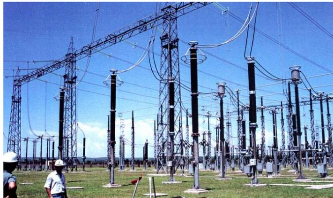
*Figura 2-1 Subestación AIS*
