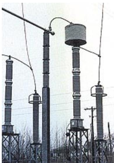
Figura 2-16 Bobina de Bloqueo
