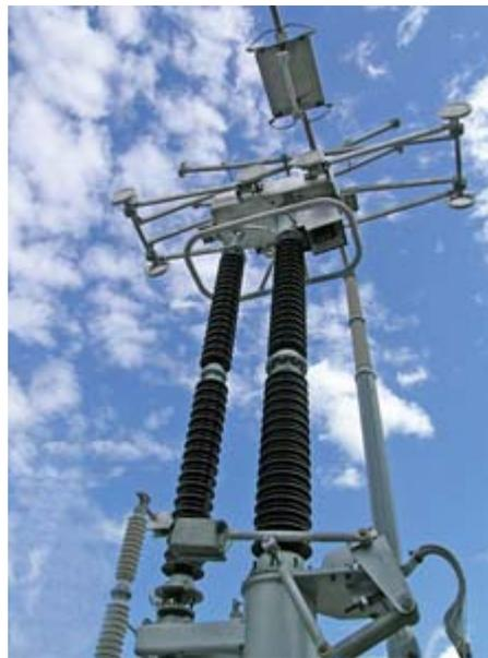
Figura 2-8 Seccionador Pantógrafo
