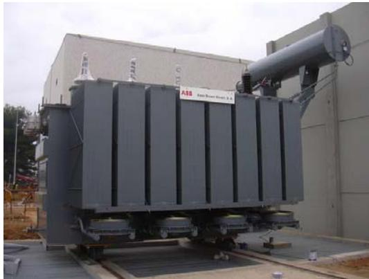
*Figura 2-20 Transformador de Potencia*
