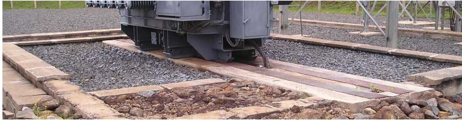
*Figura 2-41 Foso de un Transformador*
