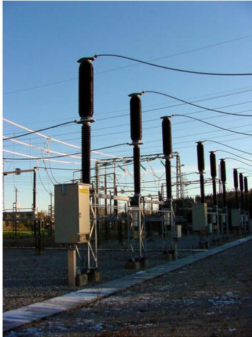
*Figura 2-6 Interruptor AIS de autosoplado*
