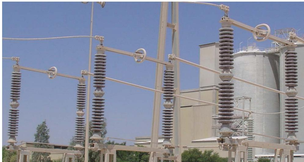
*Figura 2-7 Seccionador Dos Columnas*
