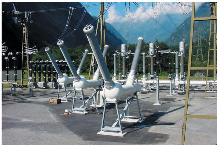
*Figura 2-4 Subestación Híbrida*
