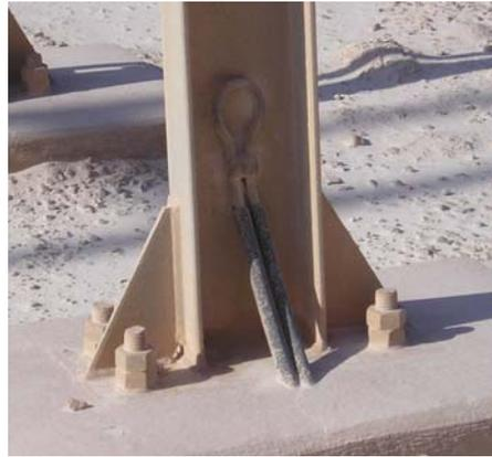
*Figura 2-30 Detalle de Puesta a Tierra*
