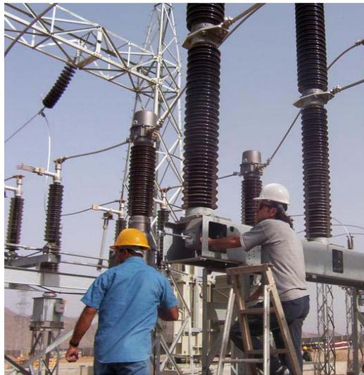
*Figura 2-42 Montaje de un Interruptor*
